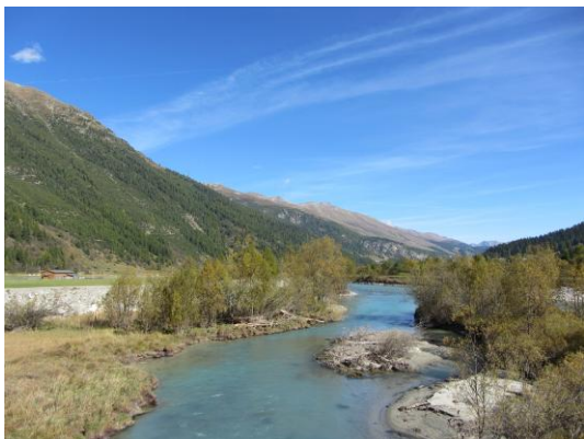
Allargamento del fiume Inn, Comune di Bever
